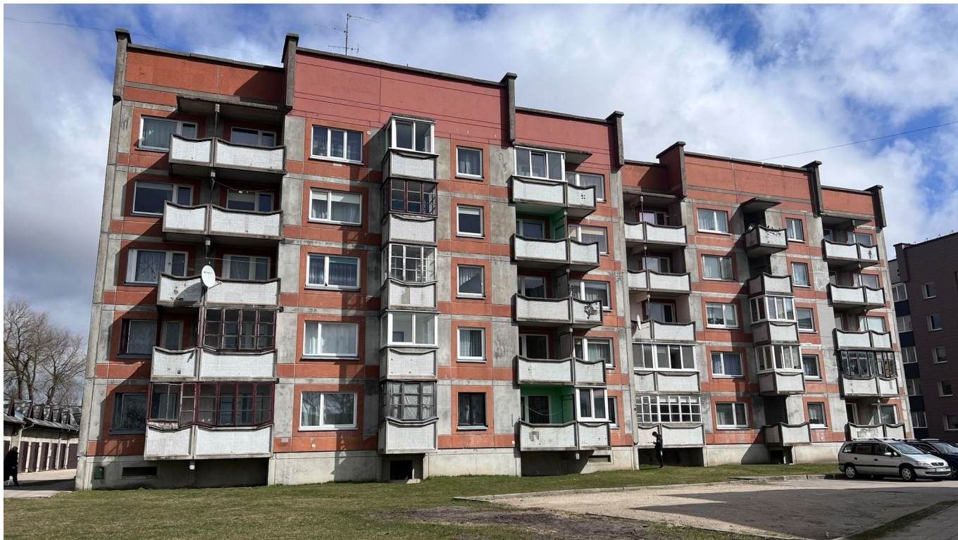
2 pav. Modernizuojamo pastato esama būklė 2022 m. balandžio mėn. fotografacija
