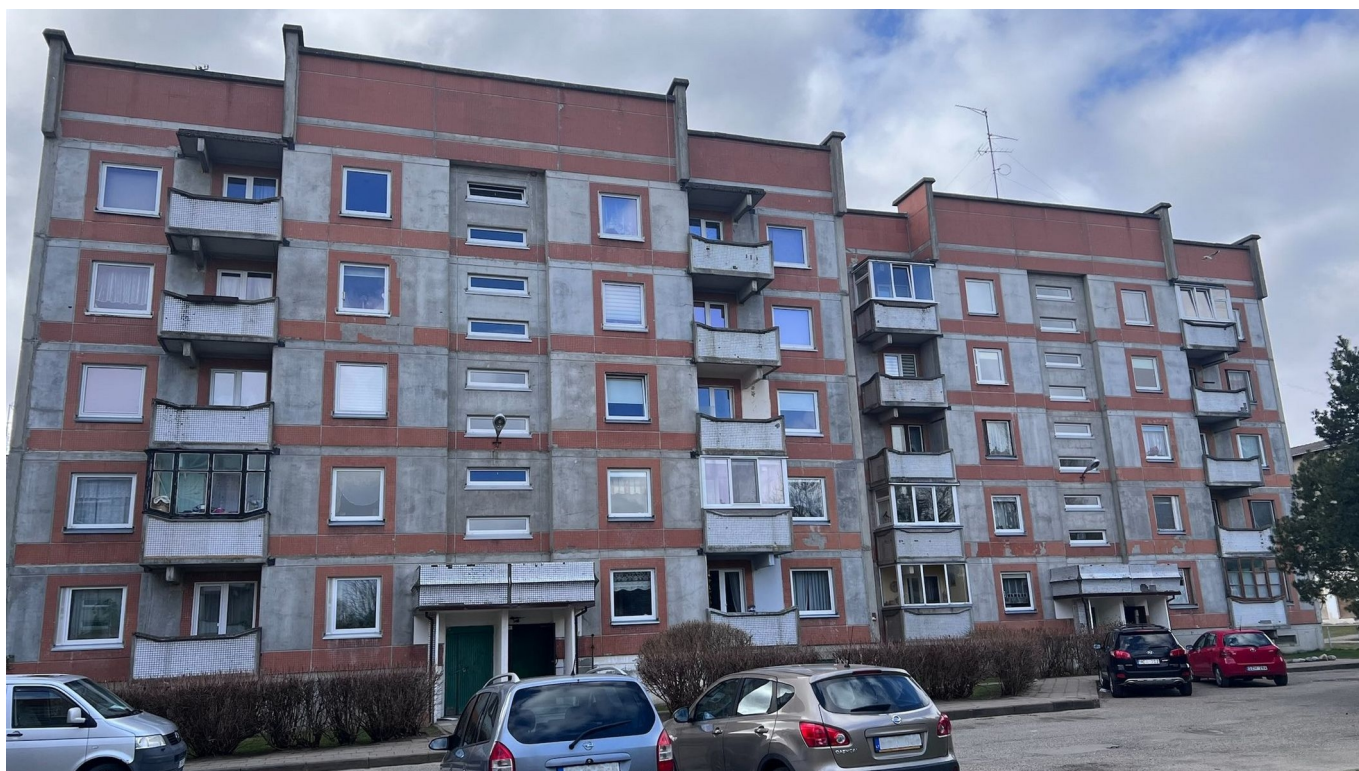
3 pav. Modernizuojamo pastato esama būklė 2022 m. balandžio mėn. fotografacija
